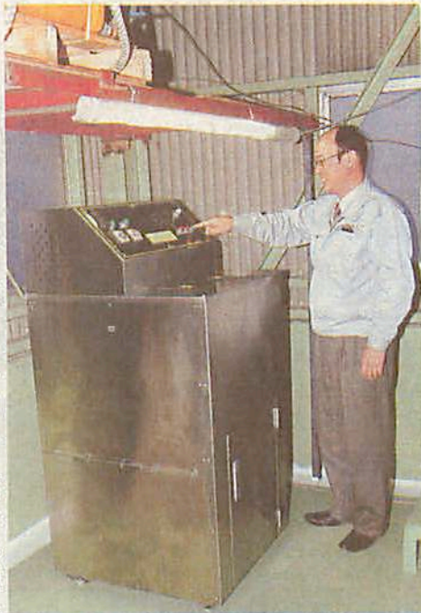
廃食用油からBDFを精製するプラントを操作するタックの瀧川社長。「エネルギーの地産地消」を目指している
